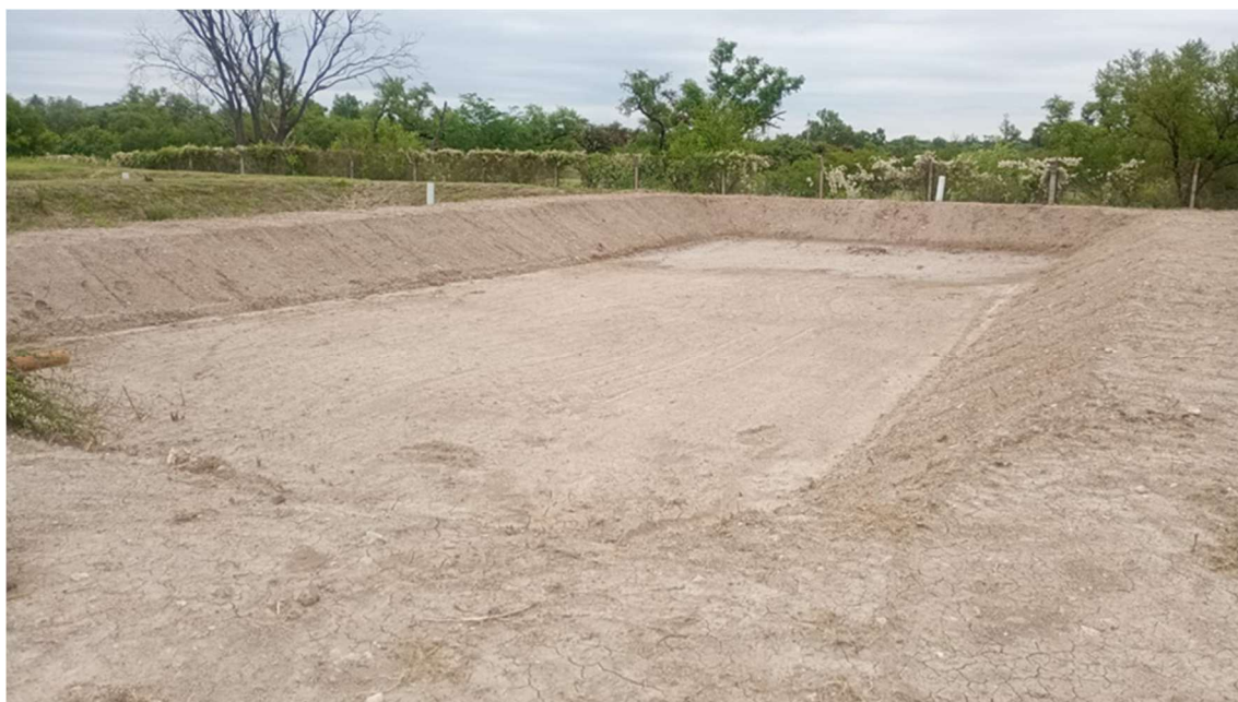
Foto 6: Estanque terminado, se observan los terraplenes internos, el caño de entrada de agua y el declive hacia el desagüe. El fondo del estanque está limpio de piedras, ramas, cascotes, etc. Fuente: G. Dapello - DNA.
